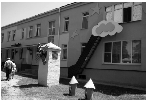
Після утеплення й кольорового оздоблення стін нізащо не скажеш, що один із корпусів закладу дошкільної освіти «Сонечко» 1964 року забудови.
