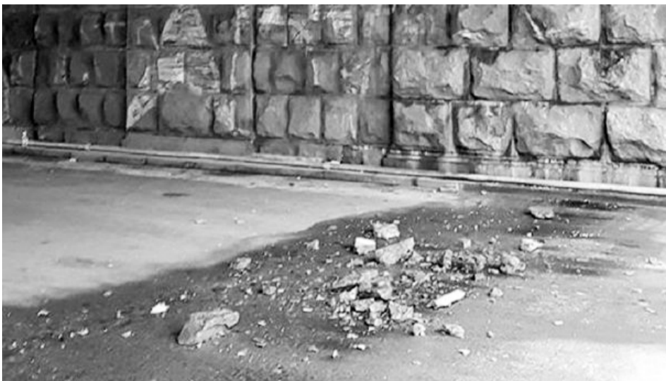
Повітрофлотський шляхопровід. «Втомився» так, що розгубив частину каміння.
