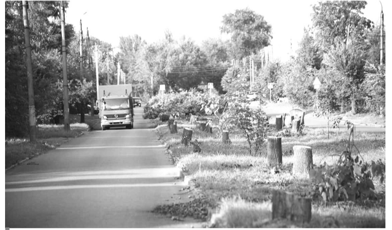
Реконструкція бульвару Богдана Хмельницького у Смілі почалася зі знищення там багаторічних дерев.
