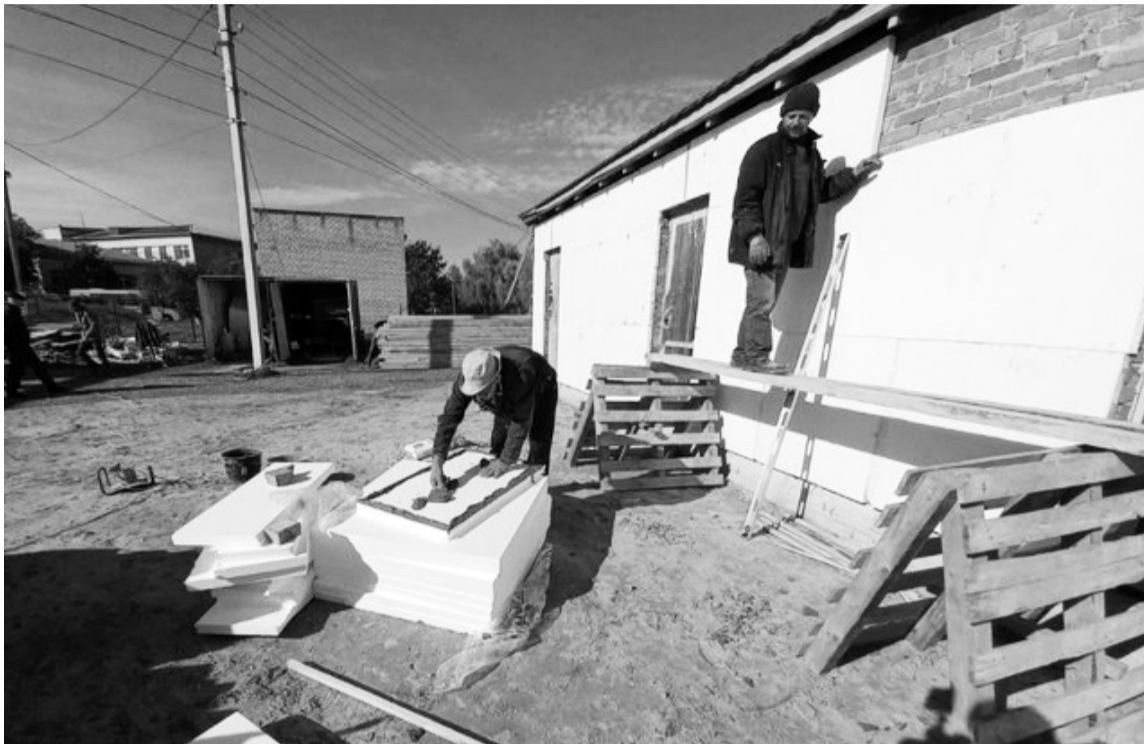
Робота з утеплення стін триває.
